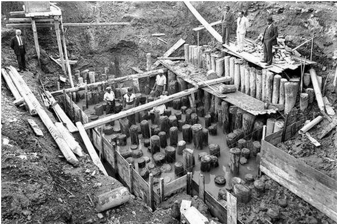
Palificata di fondazione di un edificio
