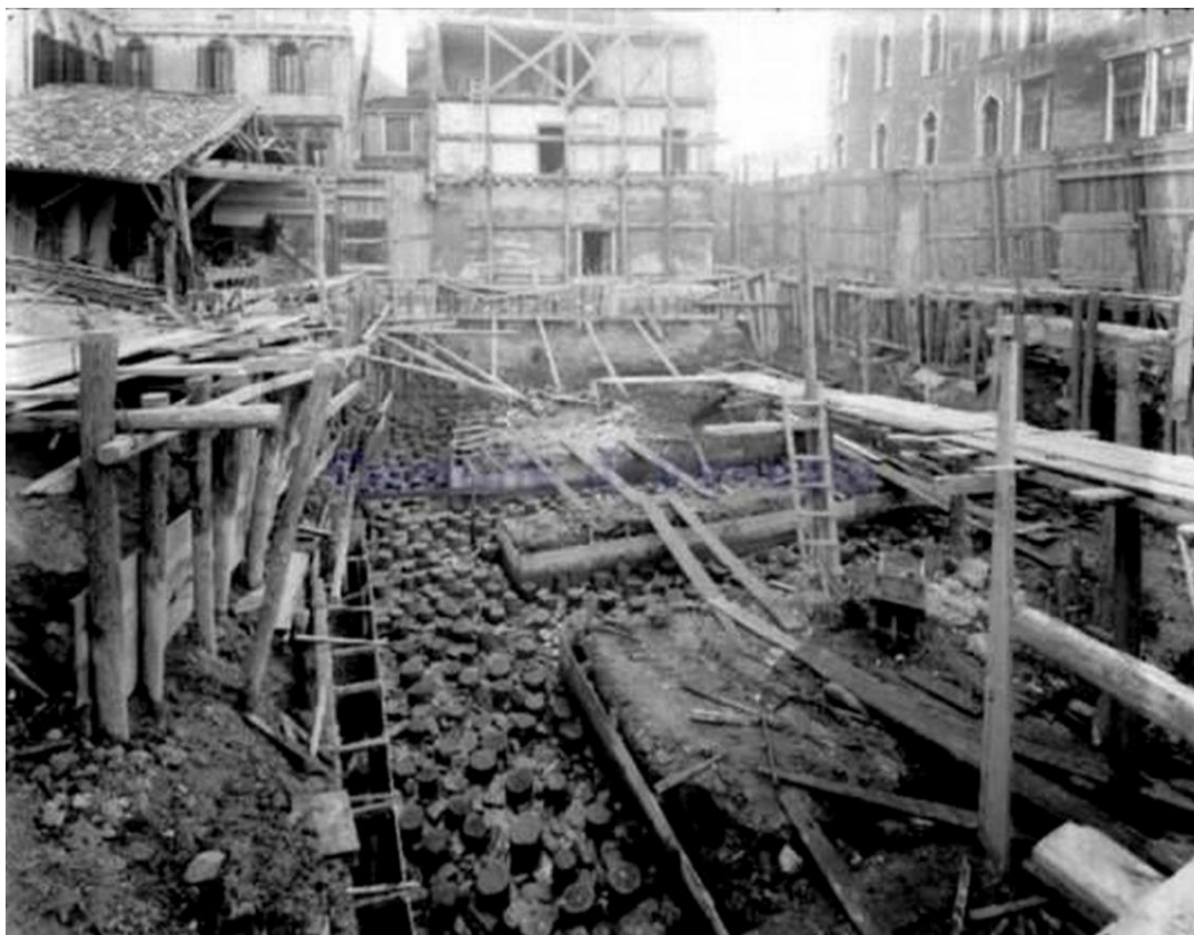
Palificata di fondazione di un edificio
