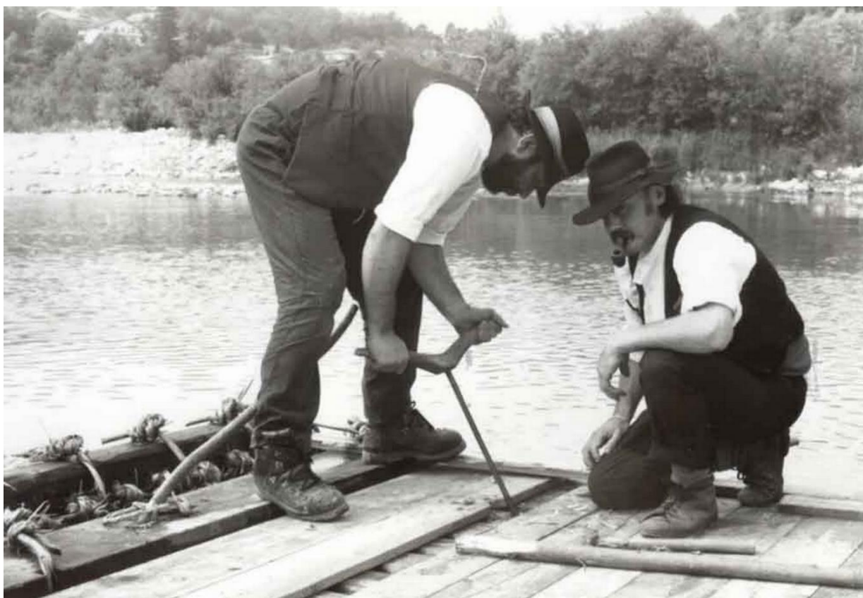
Esecuzione dei fori con la «Trivela cerva», anche 250 per ogni «còpola»
